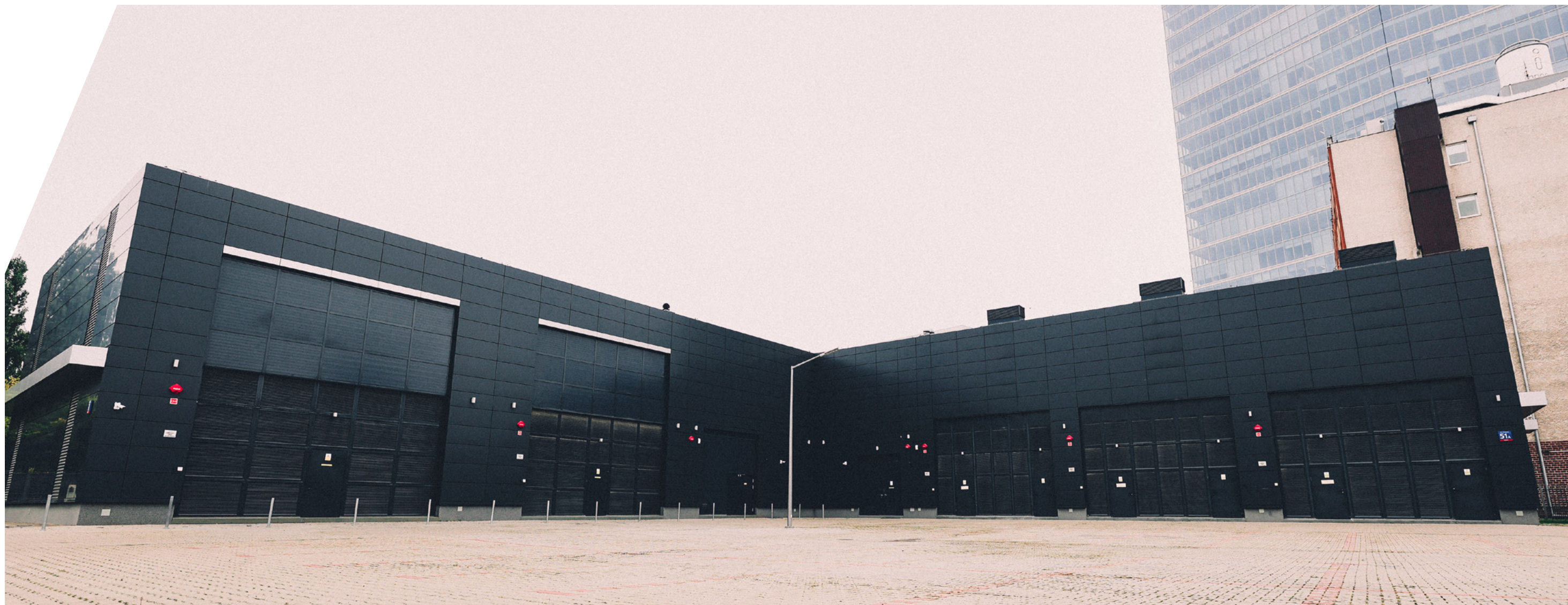
Stoen Operator, Budynek stacji elektroenergetycznej Towarowa
