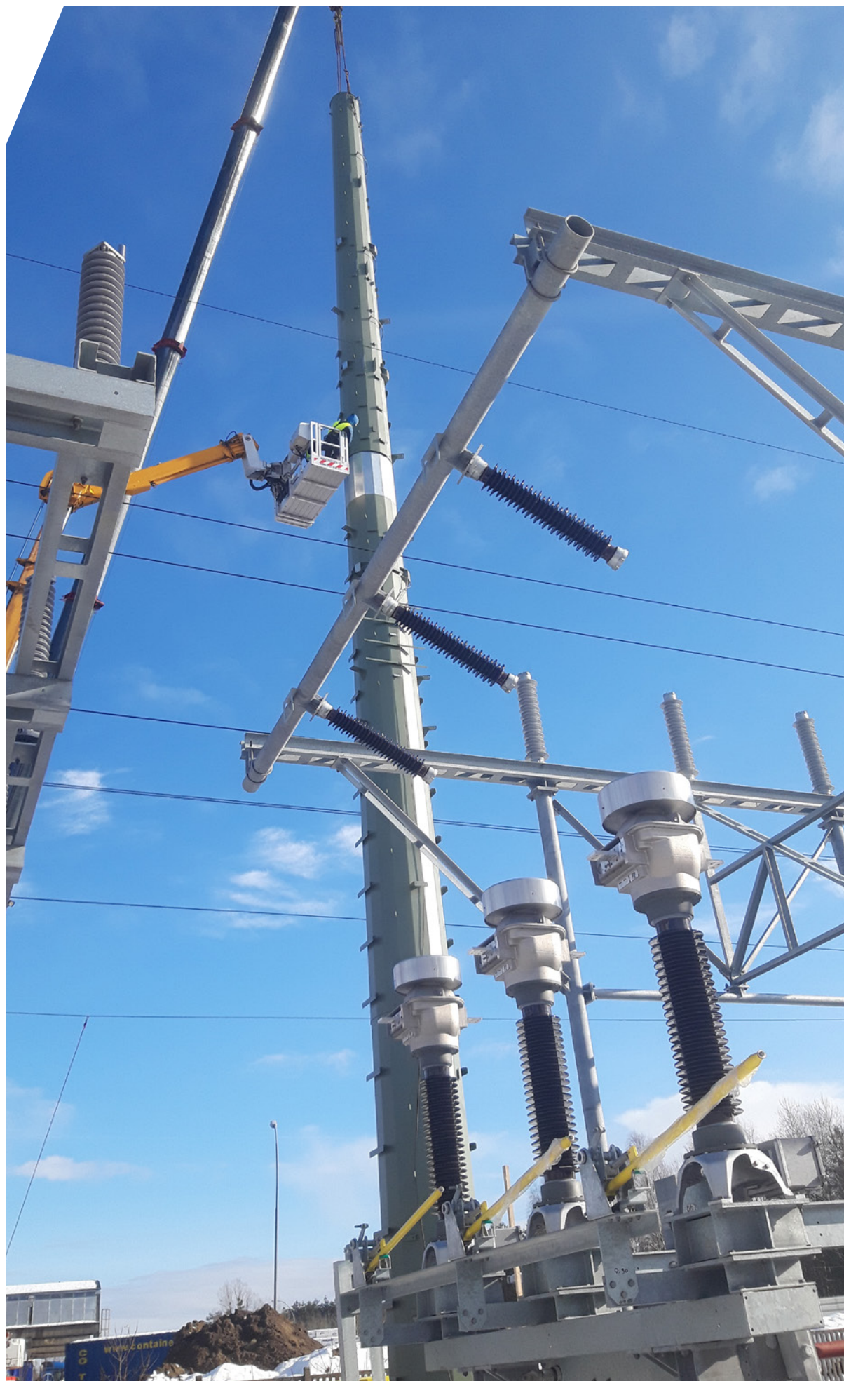
PGE Dystrybucja: Przebudowa słupa linii WN w celu wykonania nawiązań liniami kablowymi 110 kV do rozdzielni sieciowej 110 kV Budy Głogowskie
