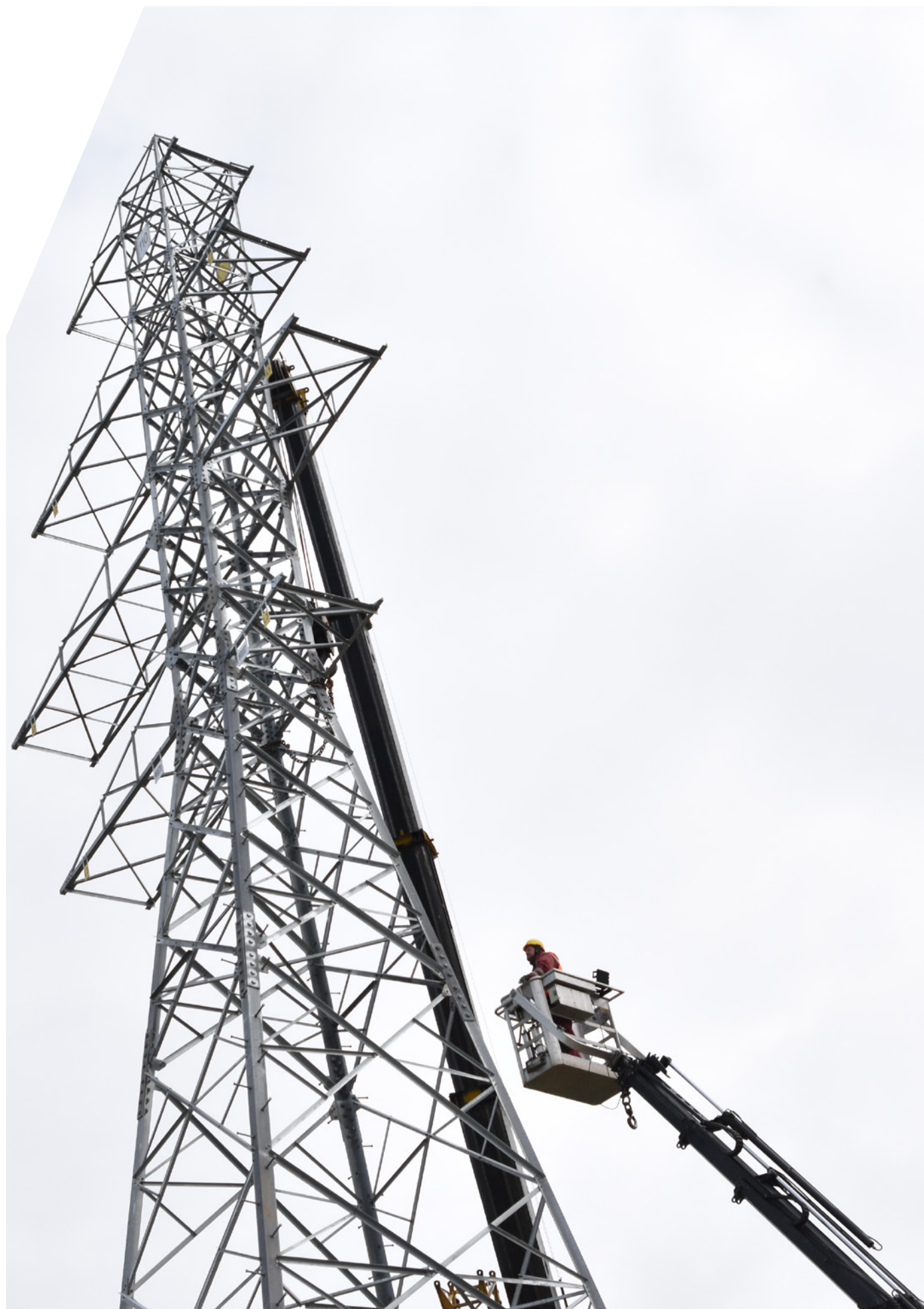
Energia-Operator, stawianie słupa dwutorowej linii napowietrznej WN
