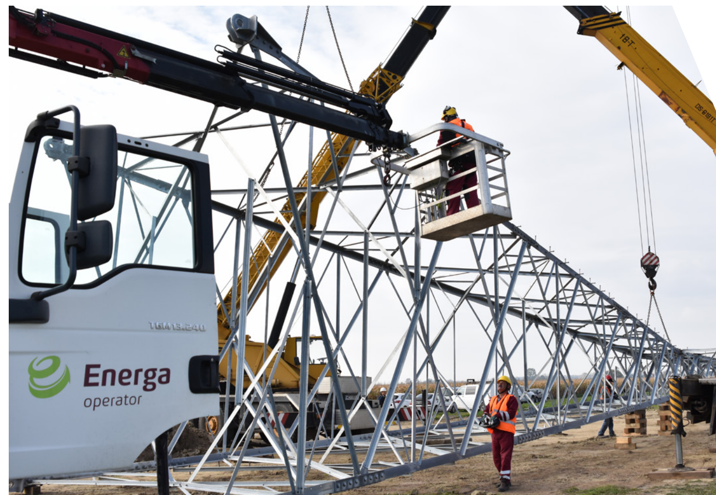
Energa-Operator, Budowa dwutorowej linii napowietrznej WN
