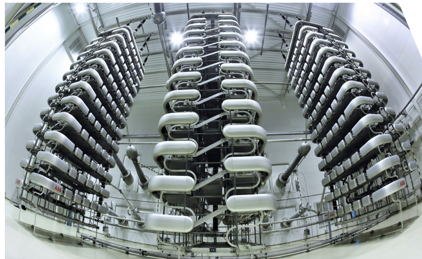
PSE, Fragment hali tyrystorowej w stacji przekształtnikowej w miejscowości Wierzbien (połączenie DC Polska - Szwecja)
