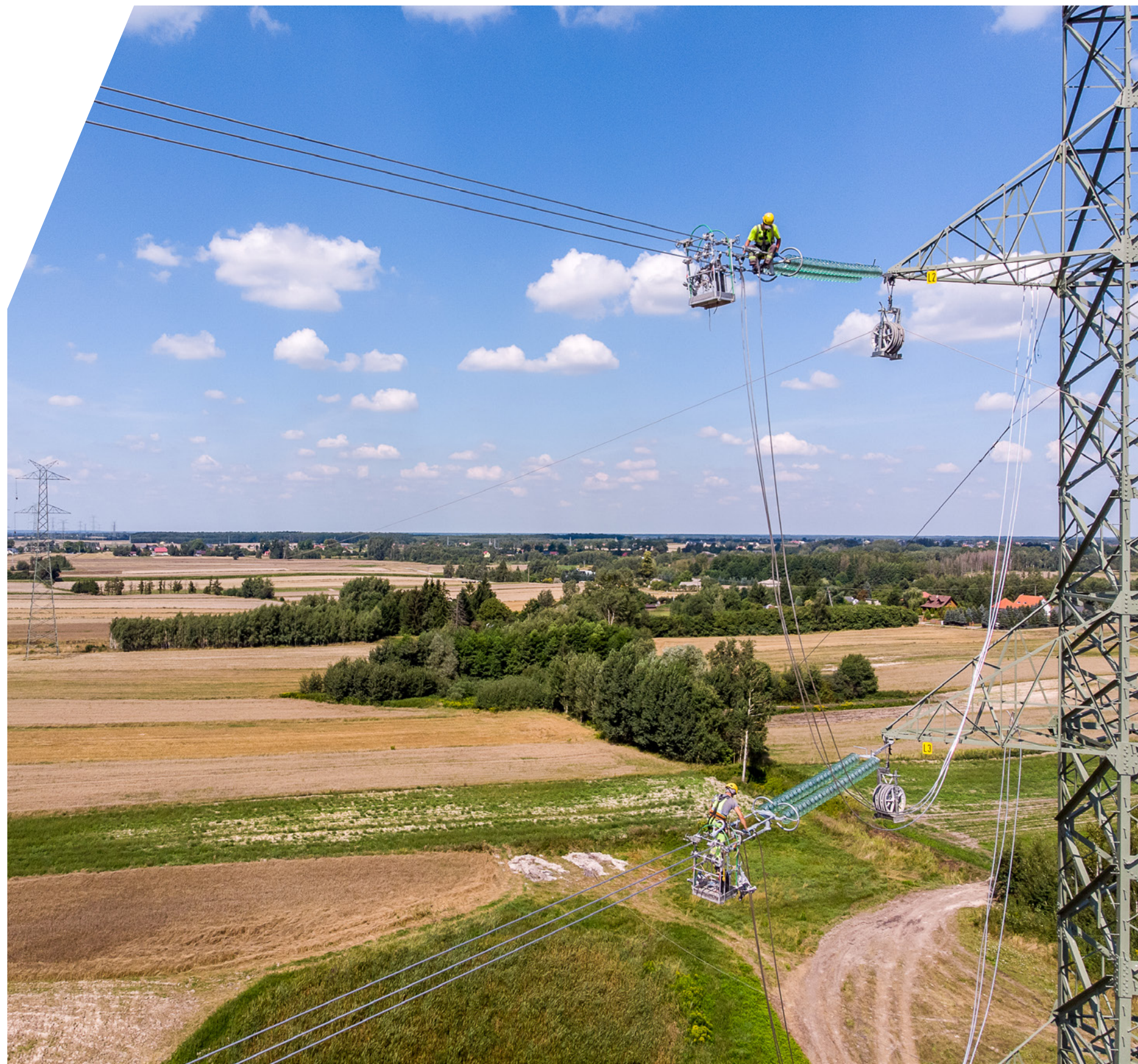
PSE, Budowa linii 400 kV Chełm - Lublin Systemowa
